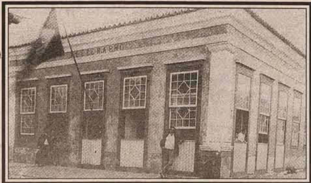
Sede dos Correios e "Telegrapho" entre a praça República Juliana e rua Barão do Rio Branco, em novembro de 1930
